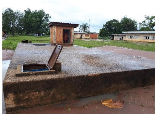
Photo 19 : Impluvium pour la collecte des eaux de pluie (© Nzila)
